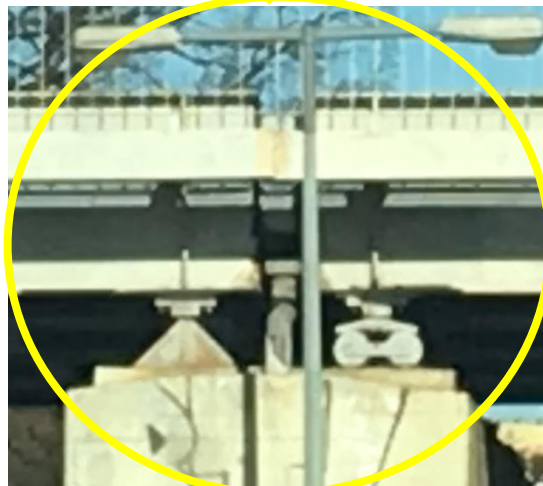
łożyska 1 mostowe (miejsce oparcia przęsa na filarze)
