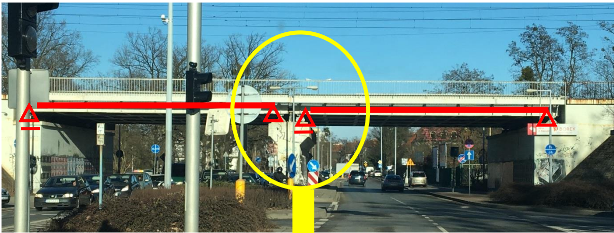
Wrocław, 2017. Wiadukt nad ul. Racławicką, fot. własna
