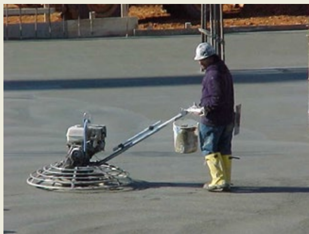
Rys. 5. Zacieranie powierzchni betonu
