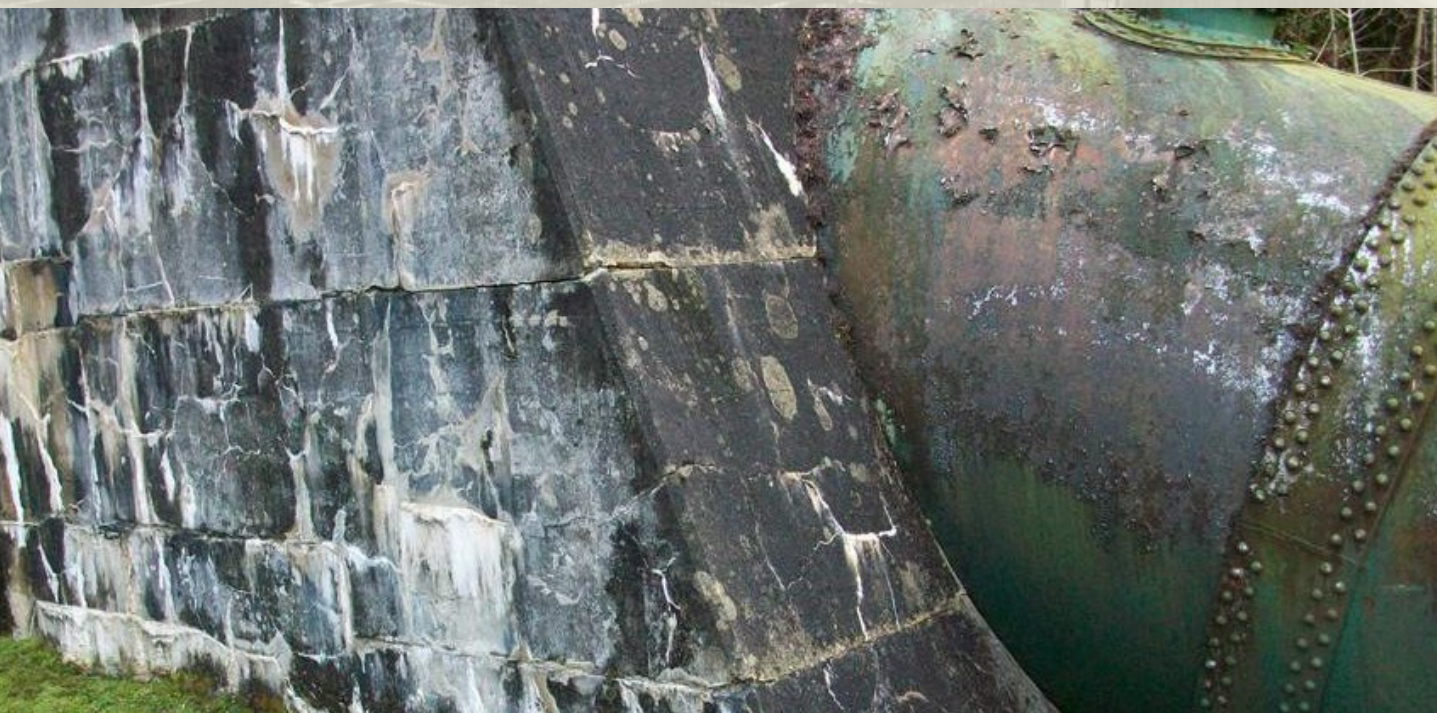
Rys. 9. Skutki reakcji alkalia-kruszywo
