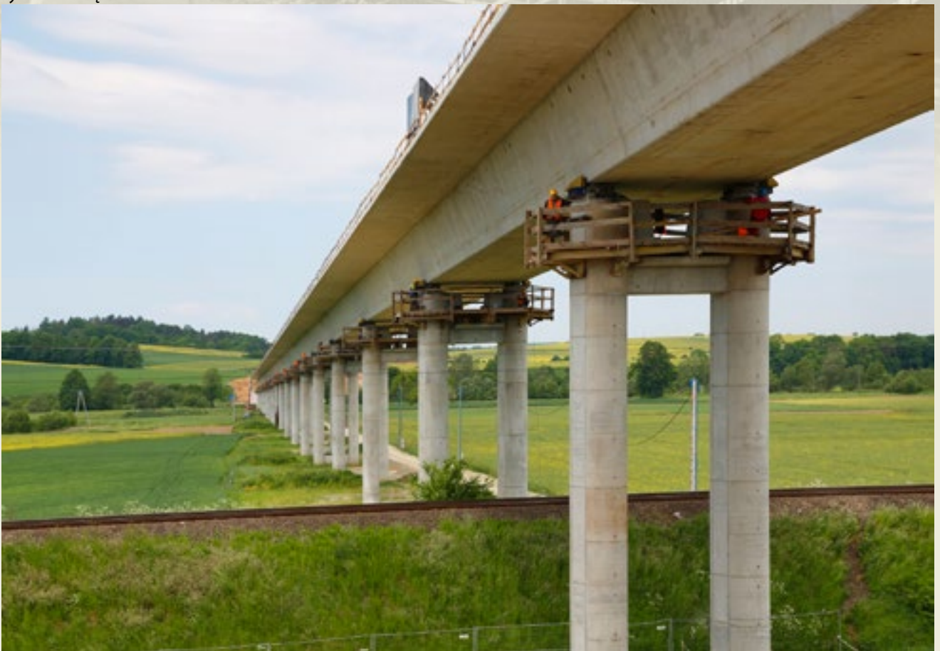
Rys. 5. Estakada na obwodnicy Kłodzka
