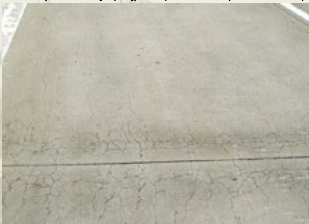
Rys.1. Zniszczenie nawierzchni i konstrukcji betonowej wywołane reakcją alkalia-kruszywo
