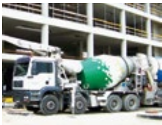
Fot. 5.10. Budowa stadionu w Lublinie – CEM III/A 42,5N-LH/HSR/NA
