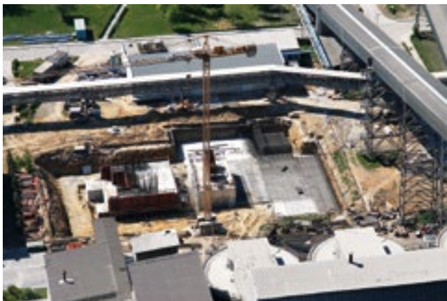
Fot. 5.5. Modernizacja Cementowni Góra
