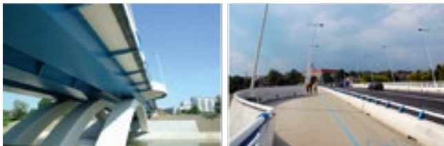
Rys. 6.66. Most zamkowy w Rzeszowie wykonany z betonu samozagęszczalnego
