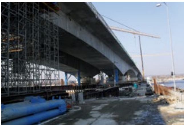
Fot. 5.2. Most przez Wisłę w ciągu autostrady A1
