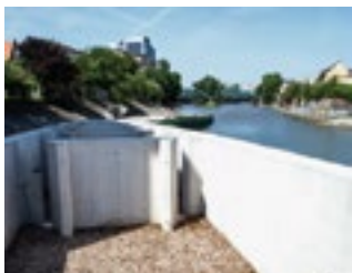
Fot. 5.8. Przebudowa Jazu Wrocław I – CEM III/A 32,5N-LH/HSR/NA
