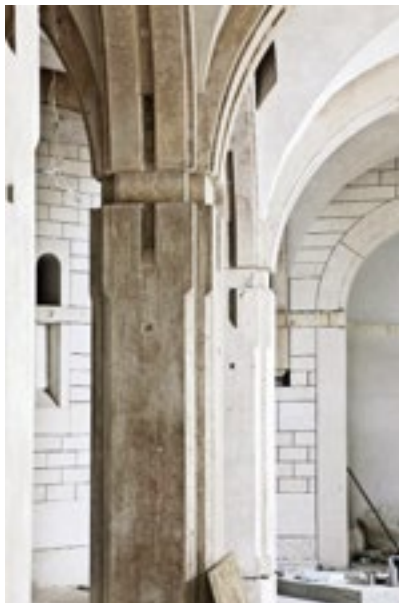
Rys. 2.6. Przykład zastosowania betonu barwionego (Centrum Jana Pawła II w Krakowie)
