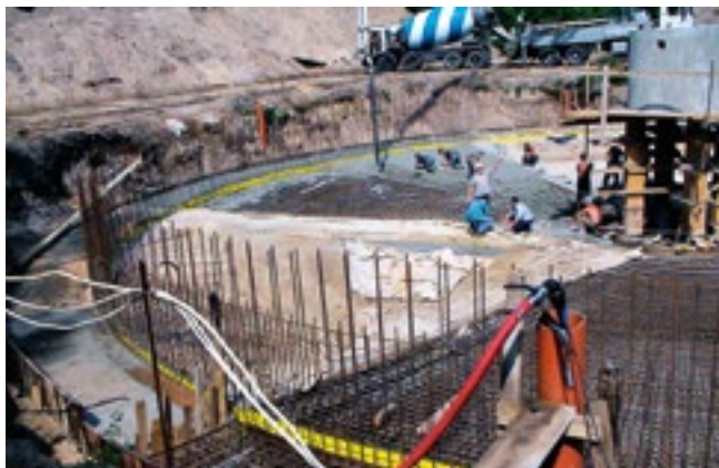
Rys. 6.91. Pielęgnacja świeżo ułożonego betonu (przykrywanie matami nasączo- nymi wodą)
