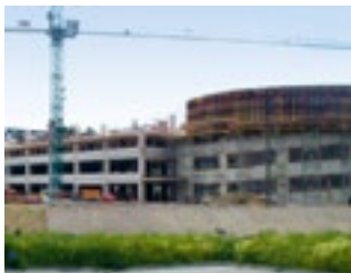
Fot. 5.7. Budowa Parkingów Wielopoziomowych „Tychy Główne” i „Tychy Lodowisko” – CEM III/A 42,5N-LH/HSR/NA, CEM II/B-S 32,5R
