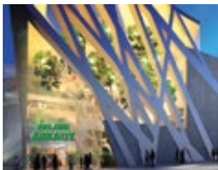
Fot. 5.9. Budowa Centrum Handlowego Zielone Arkady w Bydgoszczy – CEM III/A 42,5N-LH/HSR/NA
