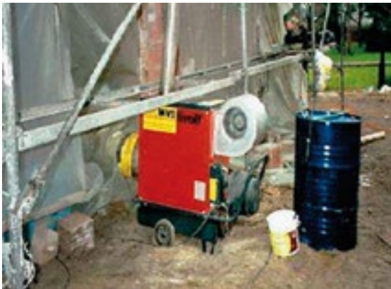
Rys. 6.99. Pielęgnacja betonu za pomocą nadmuchu ciepłego powietrza
