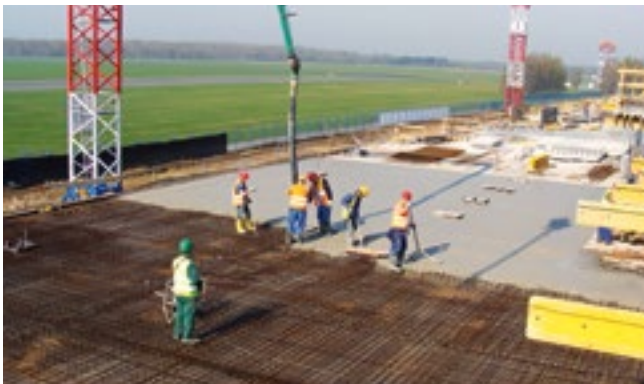
Fot. 5.1. Rozbudowa lotniska we Wrocławiu
