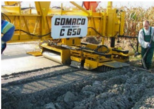
Rys. 2.9. Układanie mieszanki betonowej na drodze lokalnej Ujazd–Zimna Wódka
