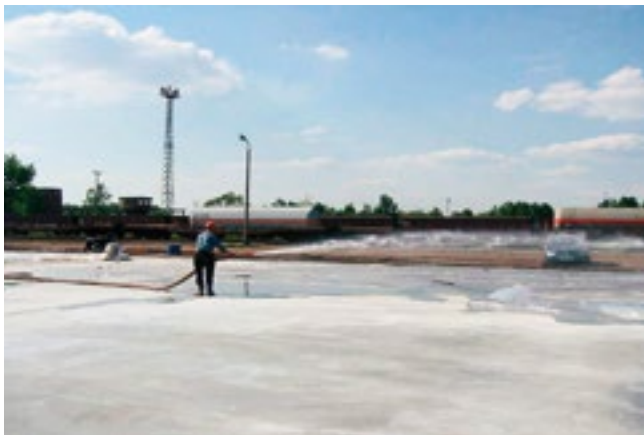
Rys. 6.92. Polewanie powierzchni betonu wodą o odpowiedniej temperaturze
