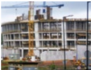
Fot. 5.6. Budowa Hali Podium w Gliwicach (Hala Gliwice) – cement hutniczy CEM III/A 42,5N-LH/HSR/NA, CEM II/B-S 32,5R
