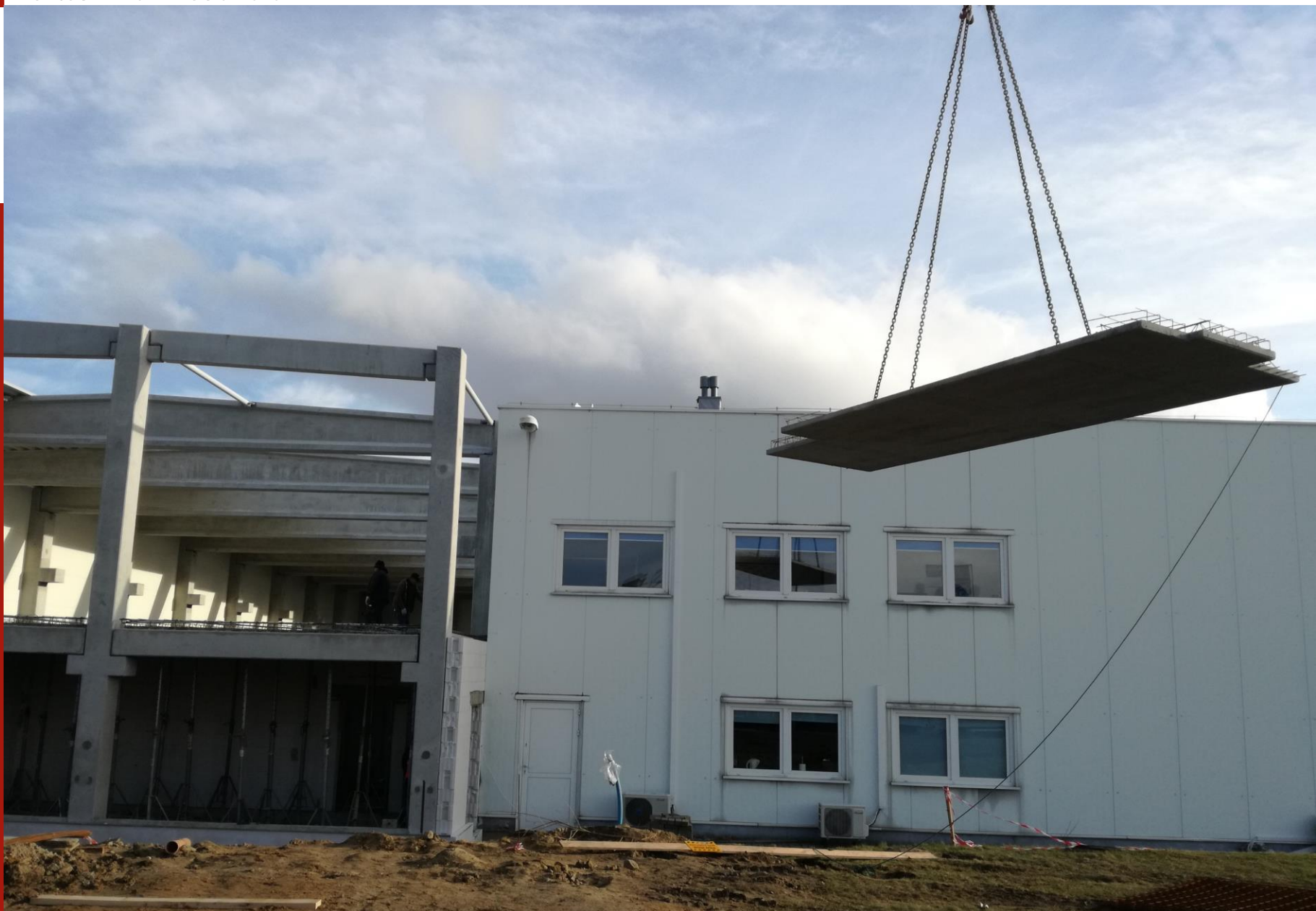
Płyty stropu Filigran podczas montażu.
