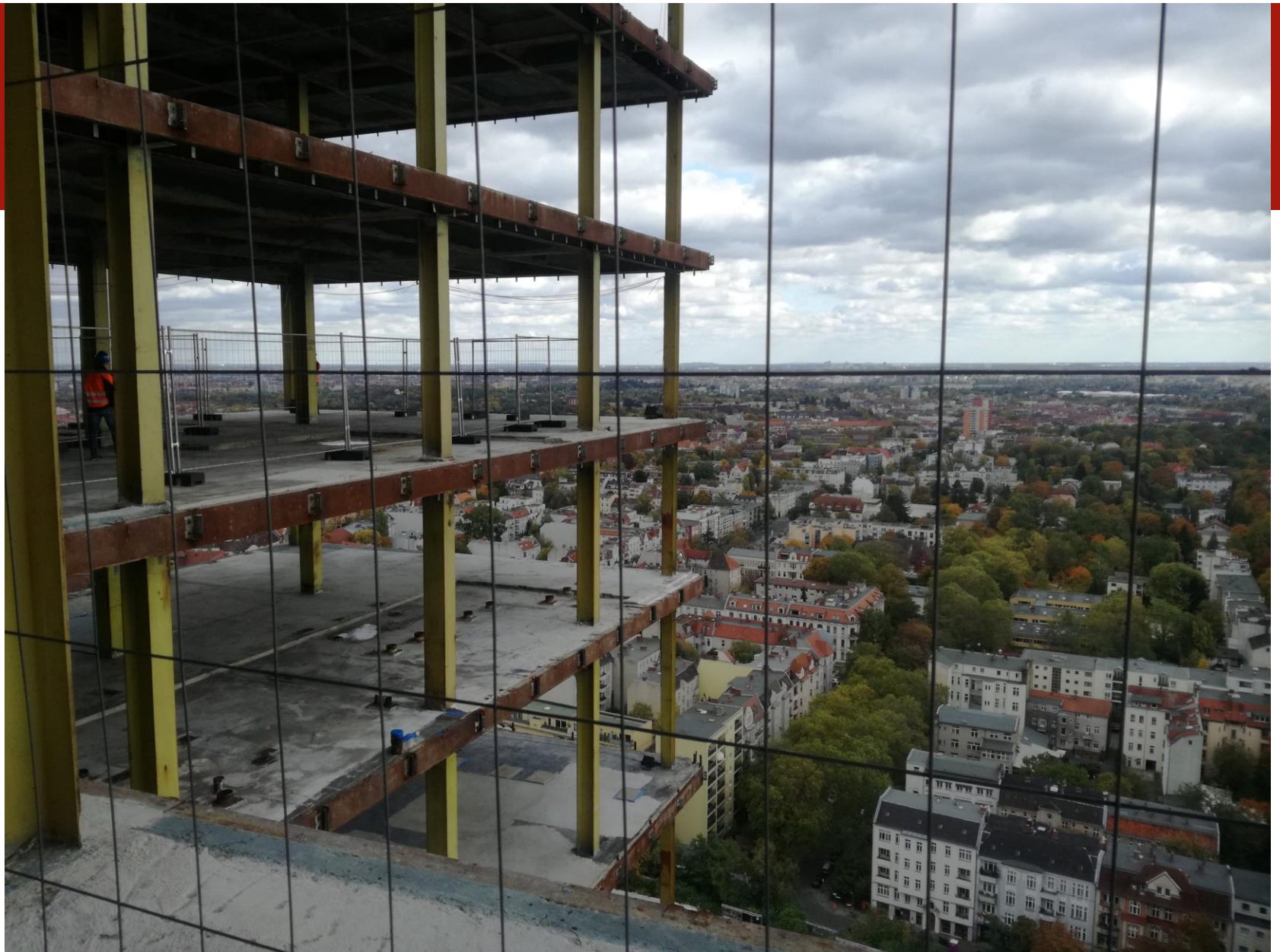
Wieżowiec podczas przebudowy.
