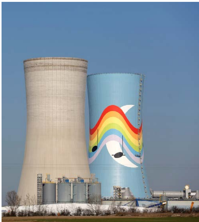
Rys. 3.55. Elektrownia Opole – zastosowano CEM III/B 42,5L-LH/SR/NA
