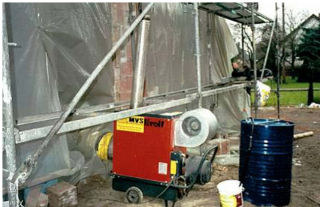
Rys. 5.196. Pielęgnacja betonu za pomocą nadmuchu ciepłego powietrza
