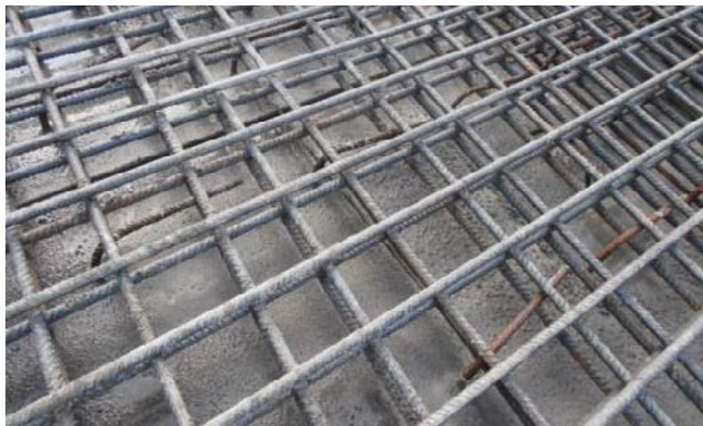
Rys. 5.67. Zastosowanie przerwy roboczej, poniżej górnej warstwy zbrojenia, przed zabudową wierzchniej warstwy mieszanki betonowej
