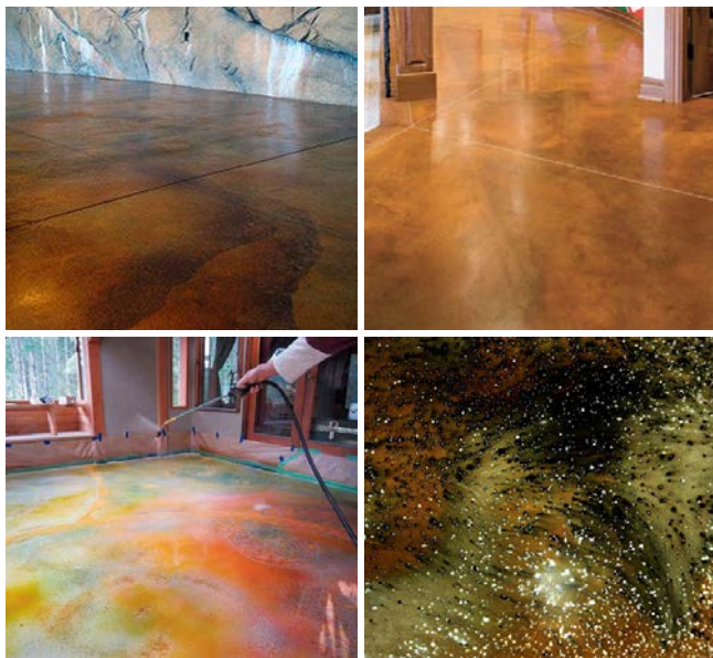
Rys. 5.158. Przykłady reaktywnego barwienia betonu
