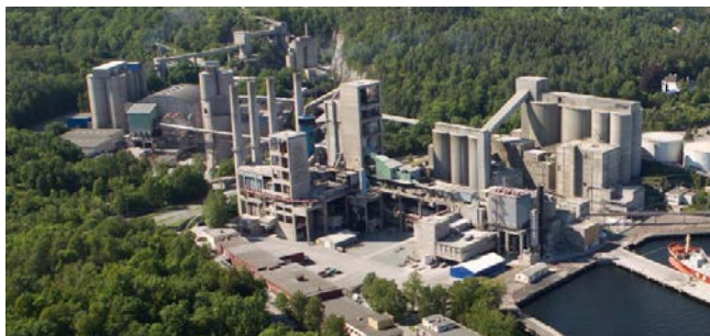
Rys. 3.35. Instalacja do wychwytywania dwutlenku węgla (post-combustion) w cementowni HeidelbergCement Norcem w Brevik (Norwegia).
