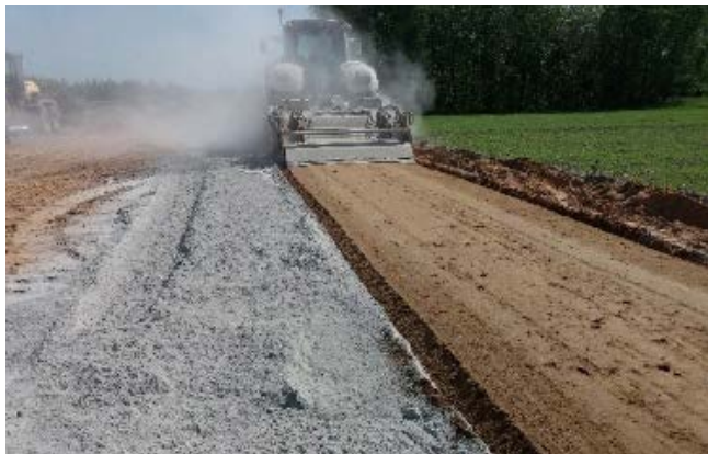
Rys. 3.80. Budowa autostrady A1, odcinek F, okolice Częstochowy
