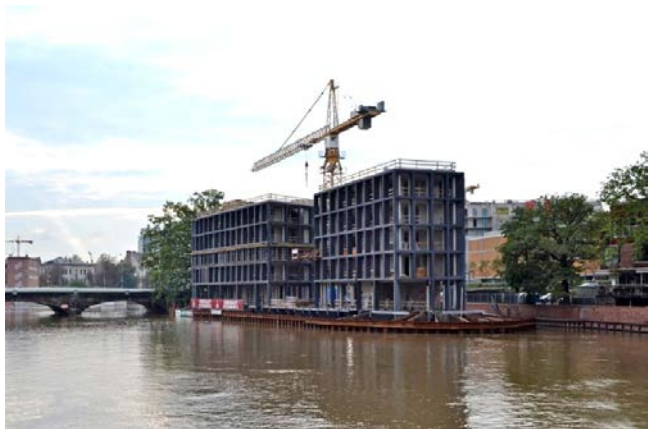
Rys. 3.62. Marina III we Wrocławiu, beton architektoniczny barwiony – zastosowano CEM III/A 42,5N-LH/HSR/NA
