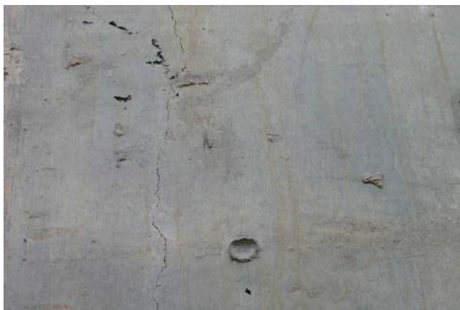
Rys. 5.176. Zarysowanie powierzchni w efekcie skurczu twardnienia
