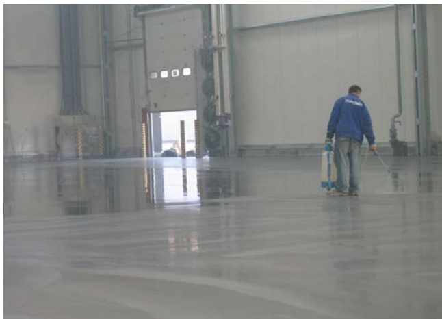
Rys. 5.184. Pielęgnacja betonu poprzez nanoszenie powłoki ochronnej
