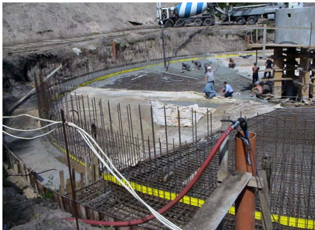
Rys. 5.179. Pielęgnacja świeżo ułożonego betonu (przykrywanie matami nasączonymi wodą)
