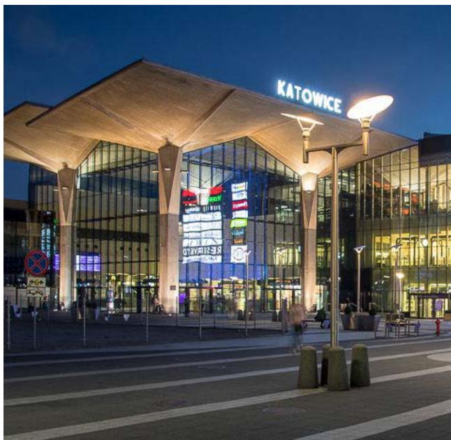
Rys. 3.59. Dworzec PKP w Katowicach – zastosowano CEM II/B-S 32,5R-NA, CEM III/A 42,5N-LH/HSR/NA
