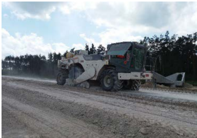
Rys. 3.79. Budowa drogi ekspresowej S7, miejscowość Brzegi, koło Kielc
