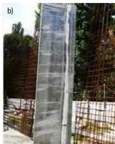
Rys. 5.183. Stosowanie osłon a) przykrywanie powierzchni betonu folią, b) owijanie słupa folią.
