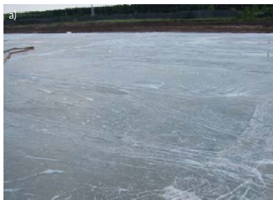
Rys. 5.183. Stosowanie osłon a) przykrywanie powierzchni betonu folią, b) owijanie słupa folią.
