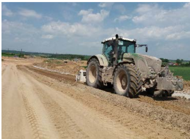
Rys. 3.81. Realizacja obwodnicy miejscowości Skąta
