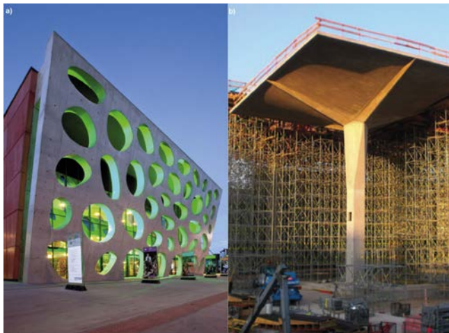
Rys. 5.119. a) Teatr Nowy w Pilźnie, b) Betonowe kielichy na dworcu w Katowicach
