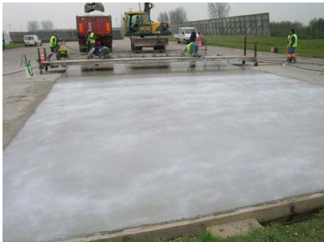
Rys. 3.73. Beton naprawczy – płyta postojowa na lotnisku w Paryżu
