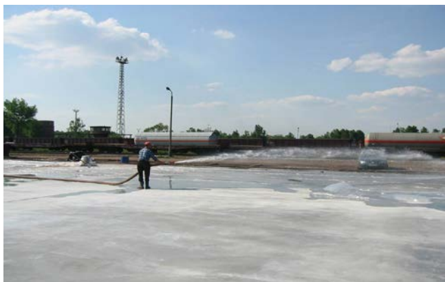
Rys. 5.180. Polewanie powierzchni betonu wodą o odpowiedniej temperaturze
