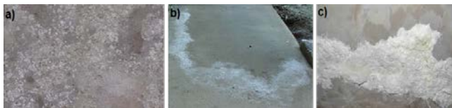
Rys. 5.201. Wykwyty węglanowe a) plamy, b) naloty, c) wykryształizowane warstwy \text{CaCO}_3
