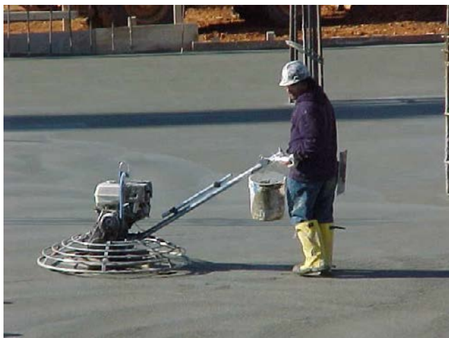
Rys. 5.68. Zacieranie powierzchni betonu
