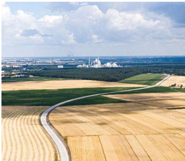
Rys. 3.61. Obwodnica Malni i Choruli, woj. opolskie (DW 423) – zastosowano CEM I 42,5N-NA
