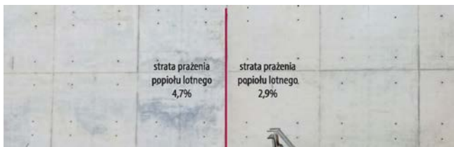
Rys. 5.122. Zmiany zabarwienia powierzchni betonu spowodowane różną zawartością strat prażenia w popiele lotnym
