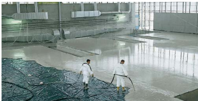
Rys. 2.10. Wylewanie płynnego jastrychu
