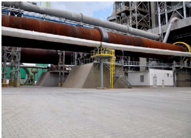
Rys. 5.152. Teren pod linią pieca nr 2 Cementowni Górażdże wykonany z fotokatalitycznej kostki zawierającej TioCem®
