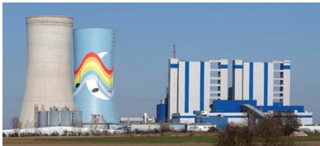
Rys. 3.60. Budowa nowych bloków energetycznych w Elektrowni Opole – zastosowano CEM III/A 32,5N-LH/HSR/NA, CEM III/B 42,5L-LH/SR/NA
