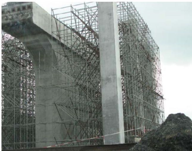
Rys. 2.8. Budowa obiektów inżynierskich w ciągu autostrady A1 odcinek Świerklany – Gorzycki
