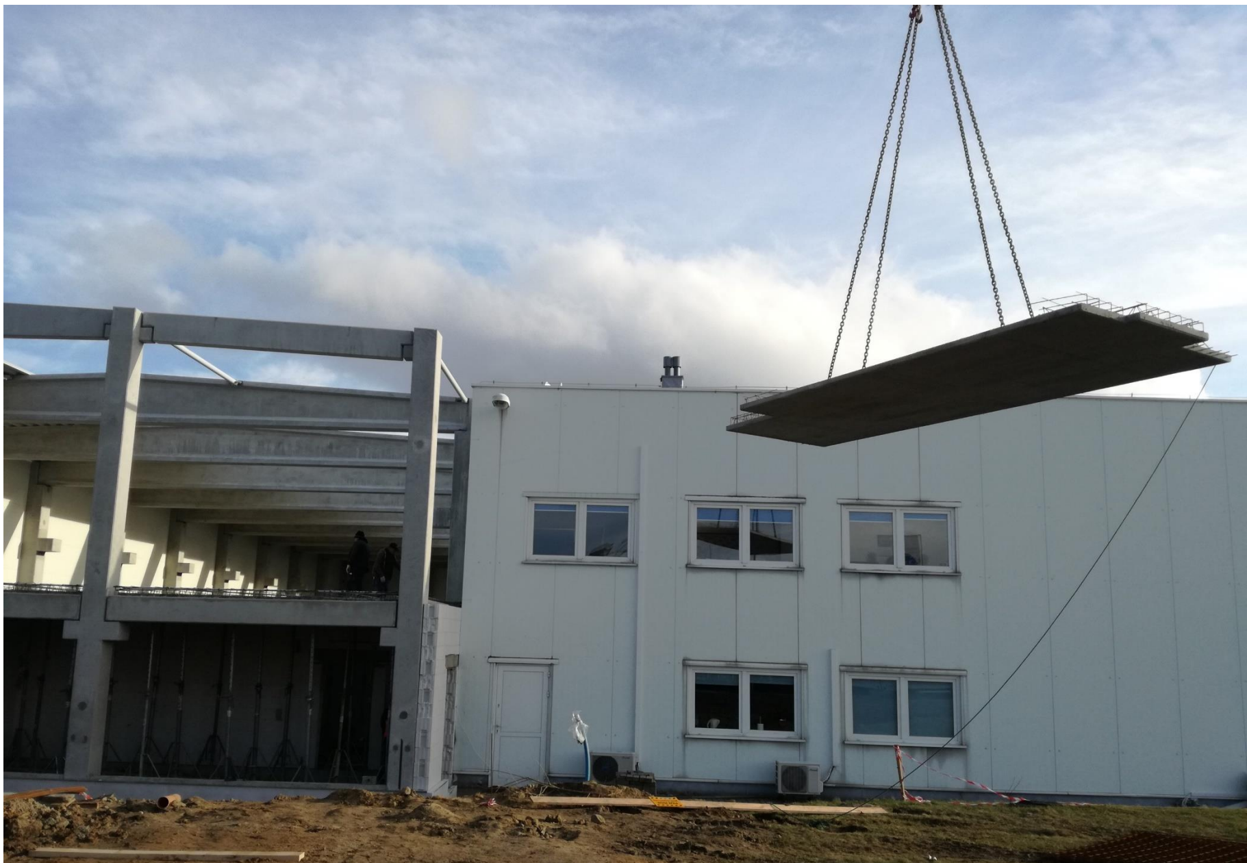
Płyty stropu Filigran podczas montażu.
