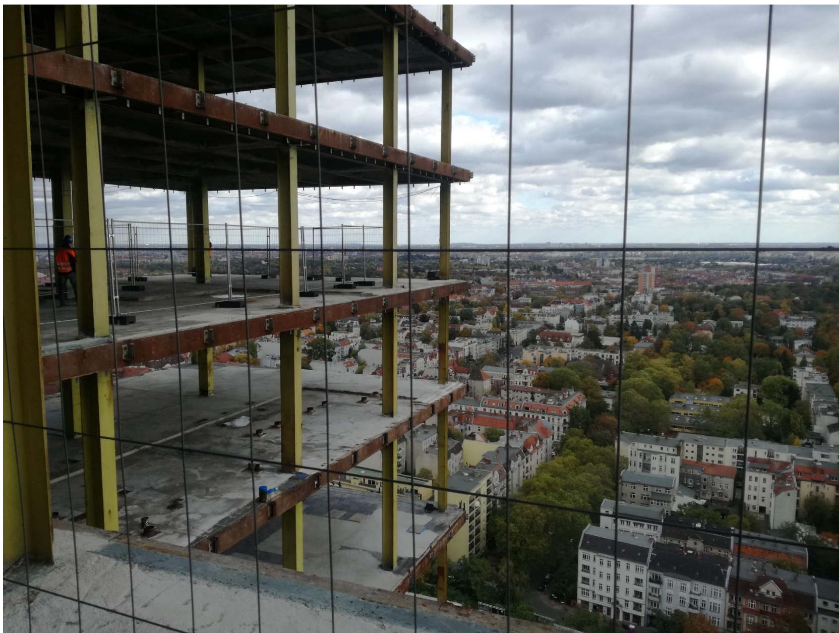
Wieżowiec podczas przebudowy.
