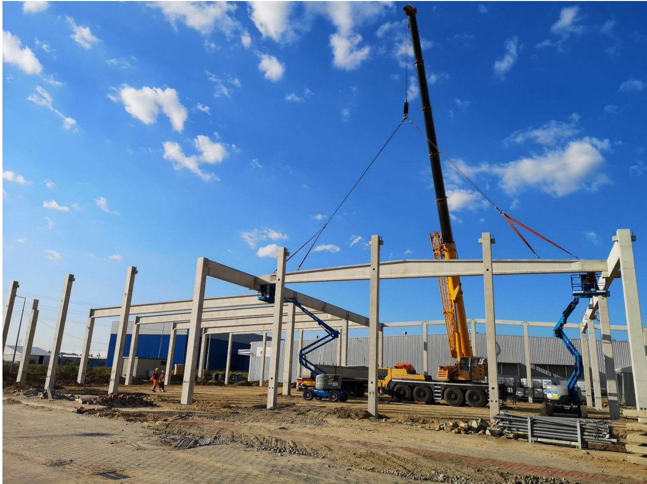
Słupy i dźwigary hali podczas transportu i montażu.
