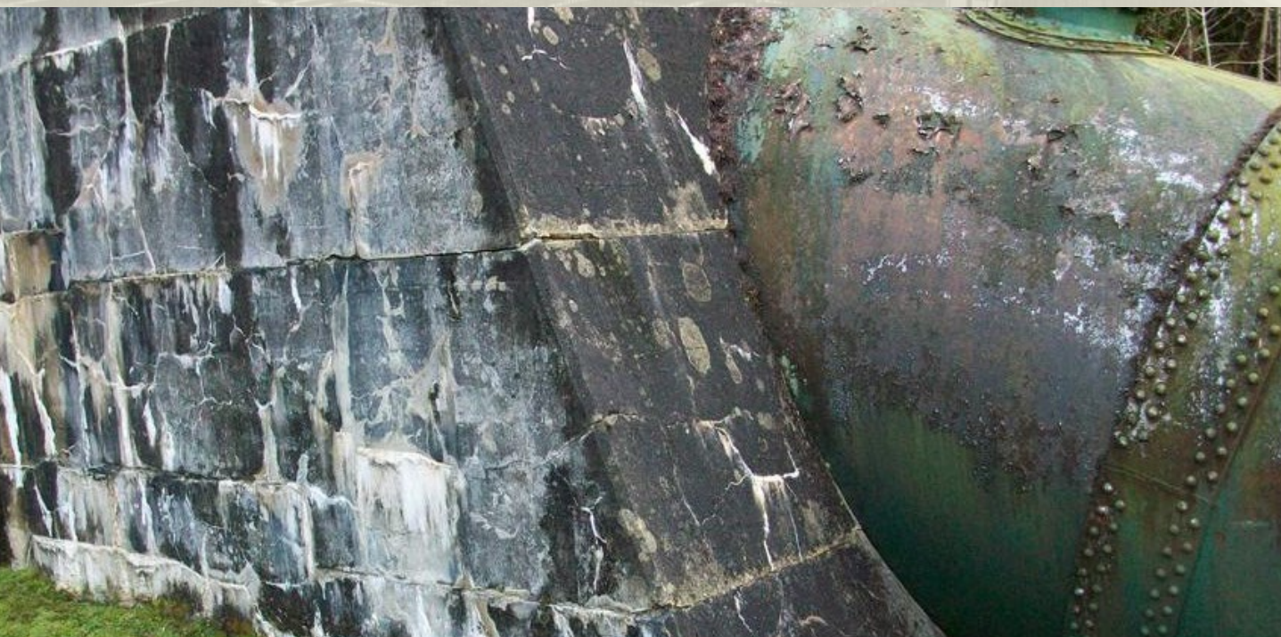
Rys. 9. Skutki reakcji alkalia-kruszywo
