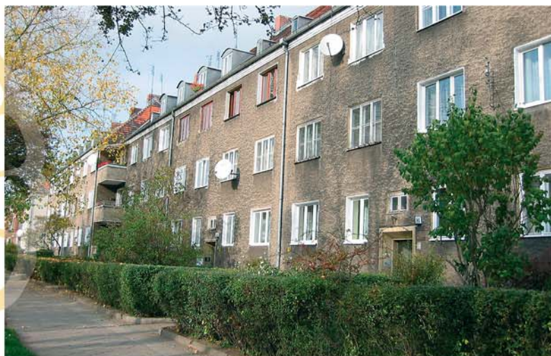
Zdjęcie 3. Ponad 70-letni tynk wapienny – brak widocznych uszkodzeń.
