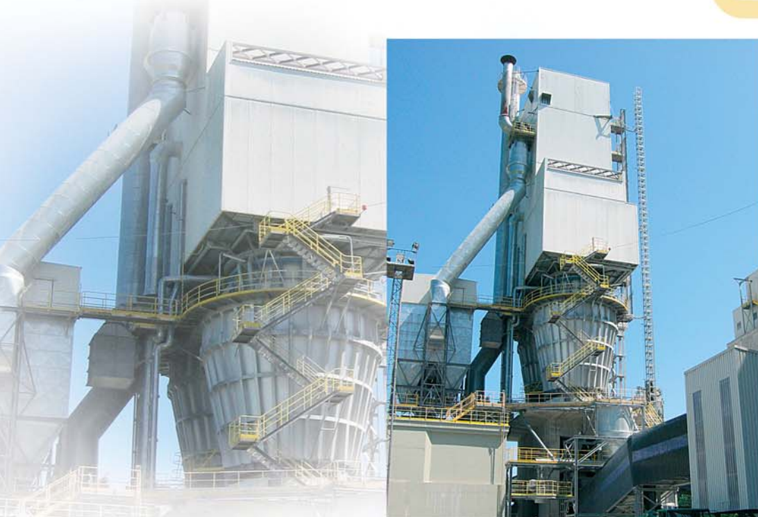
Zdjęcie 2. Nowoczesna technologia powoduje, że niektóre rodzaje wapna hydratyzowanego nie wymagają wstępnego moczenia.
