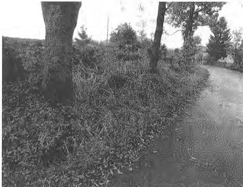
Rys 1. Zdjęcie skarpy przewidzianej do umocnienia
