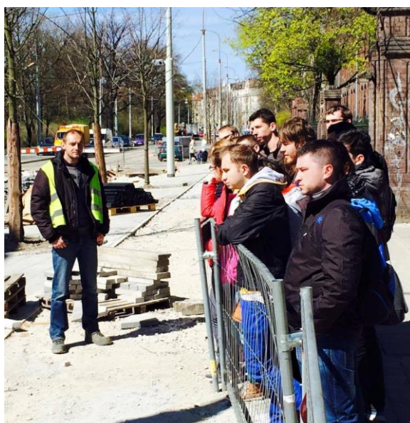
Rys. 8: Przebudowa ulicy Nowowiejskiej we Wrocławiu.
