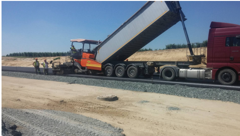
Rys. 12: Układanie warstwy podbudowy zasadniczej z betonu asfaltowego na budowie drogi ekspresowej S5
