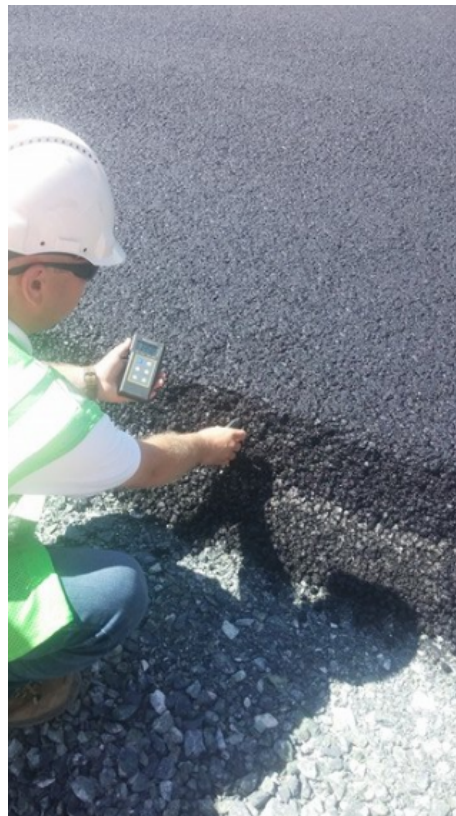
Rys. 13: Kontrola temperatury mieszanki mineralno-asfaltowej na budowie drogi ekspresowej S5
