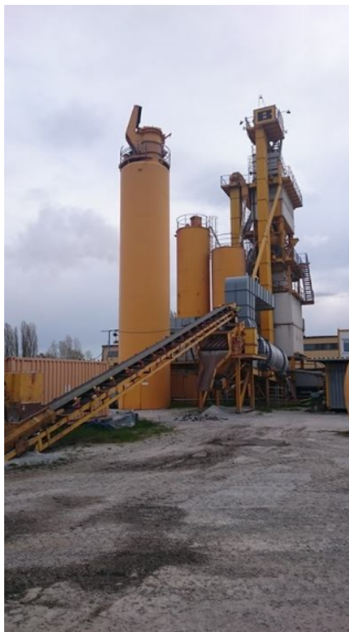
Rys. 8: Wytwórnia mas bitumicznych firmy Bergerbau we Wrocławiu
