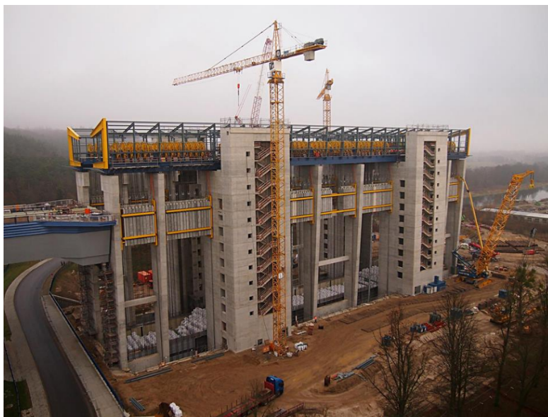
Rys. 3: Budowa nowej podnośni statków niedaleko Berlina.
