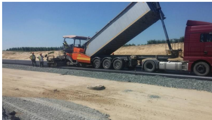
Rys. 7: Układanie warstwy podbudowy zasadniczej z betonu asfaltowego na budowie drogi ekspresowej S5
