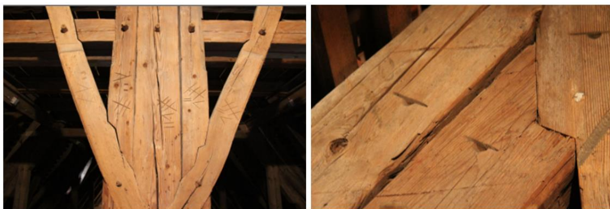
Rys. 3.3. Znaki ciesielskie widoczne na elementach więźby dachowej kościoła Najświętszej Marii Panny w Ingolstadt z 1492 r.
