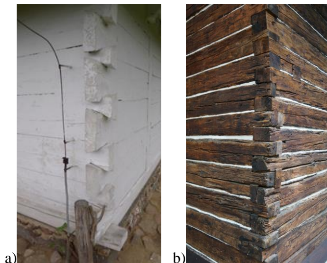
Rys. 3.9. Przykłady łączenia ścian wieńcowych w narożach a) z ostatkami (chałupa z Rębowa z II poł. XIX w., obecnie w Muzeum Wsi Mazowieckiej w Sierpcu [54]), b) bez ostatków (kościół św. Jana Nepomucena z I poł. XVII w., w Parku Szczytnickim we Wrocławiu [98])
