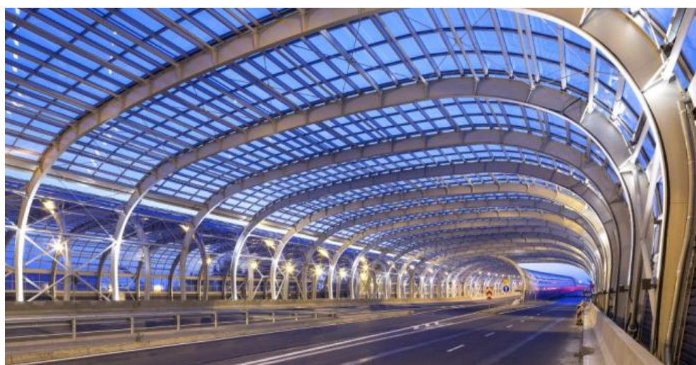
Rys. 1.2. Zastosowanie dwuteowych kształtowników giętych na zimno: a) przekrycie łukowe hali [17], b) łukowe tunele akustyczne [źródło: www.koenigstahl.pl ], c) architektoniczne wykończenia elewacji [17]
