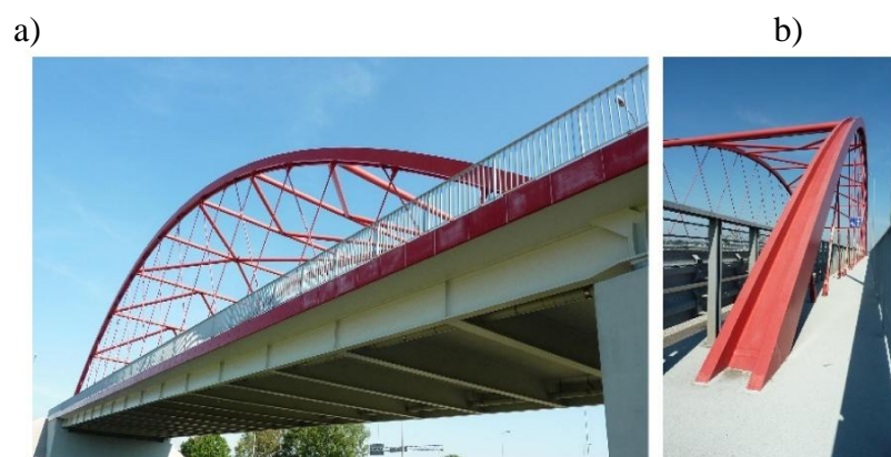
Rys. 1.3. Wiadukt WD-57 w Rawiczu nad drogą S5: a) widok ogólny wiaduktu, b) widok dźwigara łukowego wg. [35], [81]
