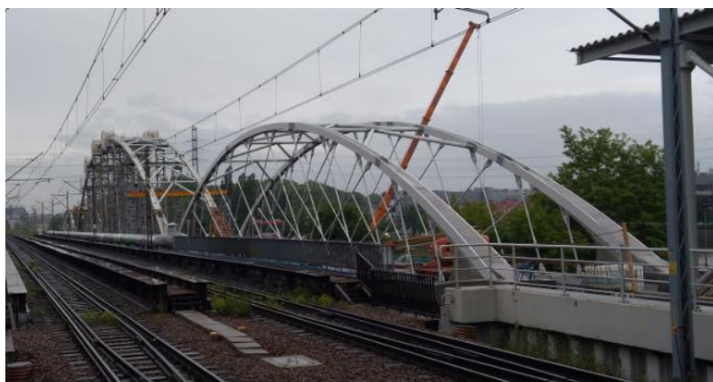
Rys. 8.4. Widok mostu przez Wisłę w Krakowie [zdjęcie: W. Lorenc]
