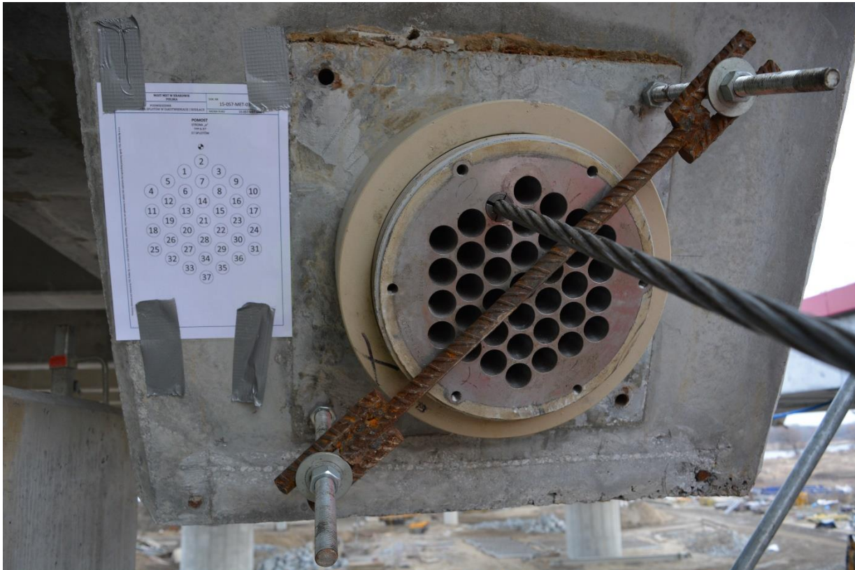
Rys. 1.6. Widoczne zakotwienie pierwszego splotu wanty na budowie podwieszono mostu przez Wisłę w ciągu drogi ekspresowej S7 w Krakowie [źródło własne]
