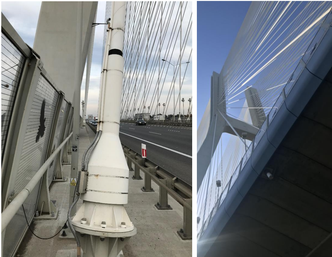
Rys. 1.7. Górna część zakotwienia czynnego (z lewej) wanty i widok kotwienia od spodu konstrukcji pomostu (z prawej). System HD2000 Freyssinet (most Rędziński we Wrocławiu, źródło własne)
