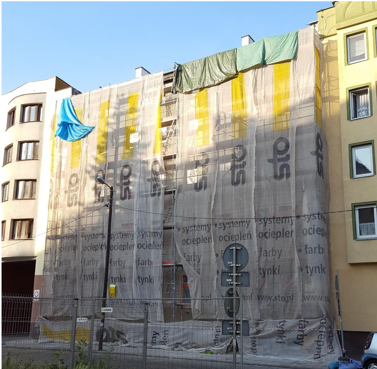
Rys. 9.2 Widok na analizowane rusztowanie budowlane (źródło fotografii: archiwum projektu ORKWiZ)
