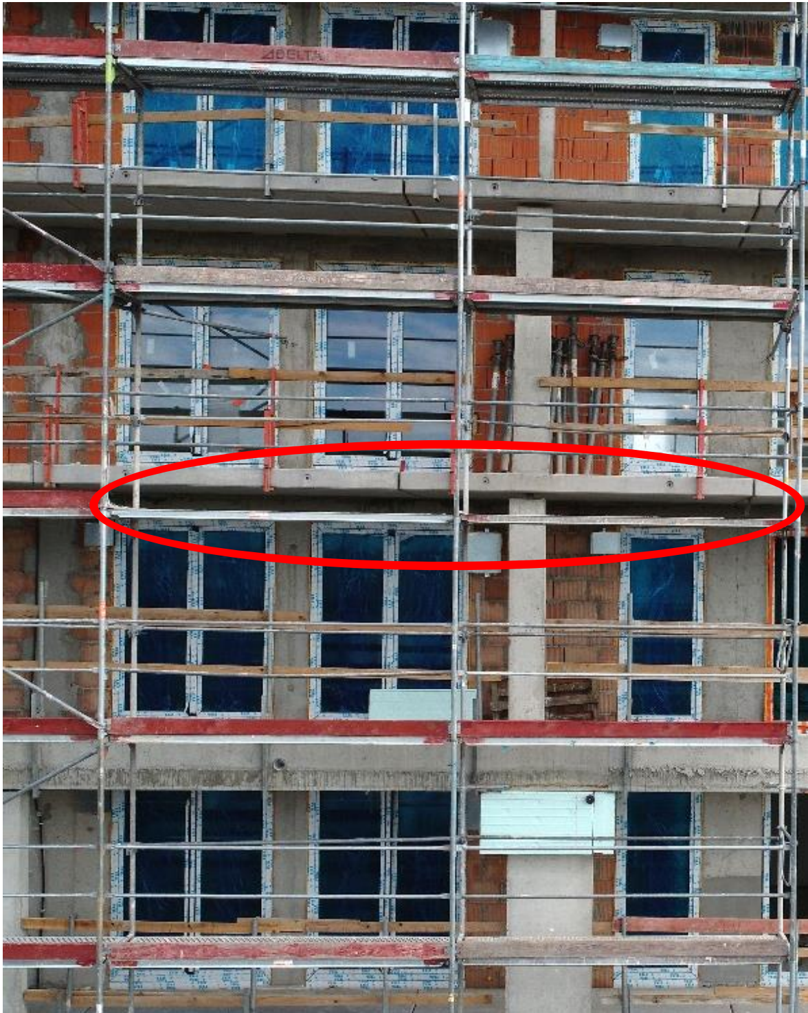
Rys. 4.1 Widok na balustradę – brak belek krawężnikowych na dwóch sąsiednich polach (opracowanie własne z wykorzystaniem BSP)
