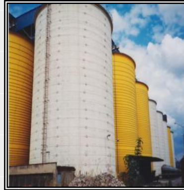
Silosy na rzepak ceramiczne i żelbetowe w Brzegu
