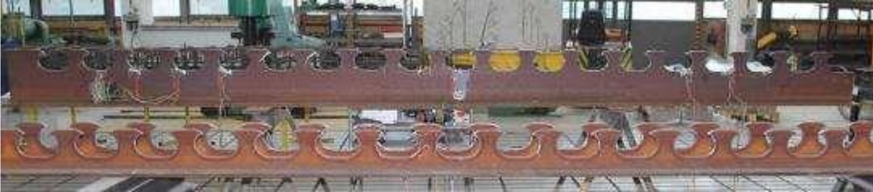
Stalowa część belki przed betonowaniem
