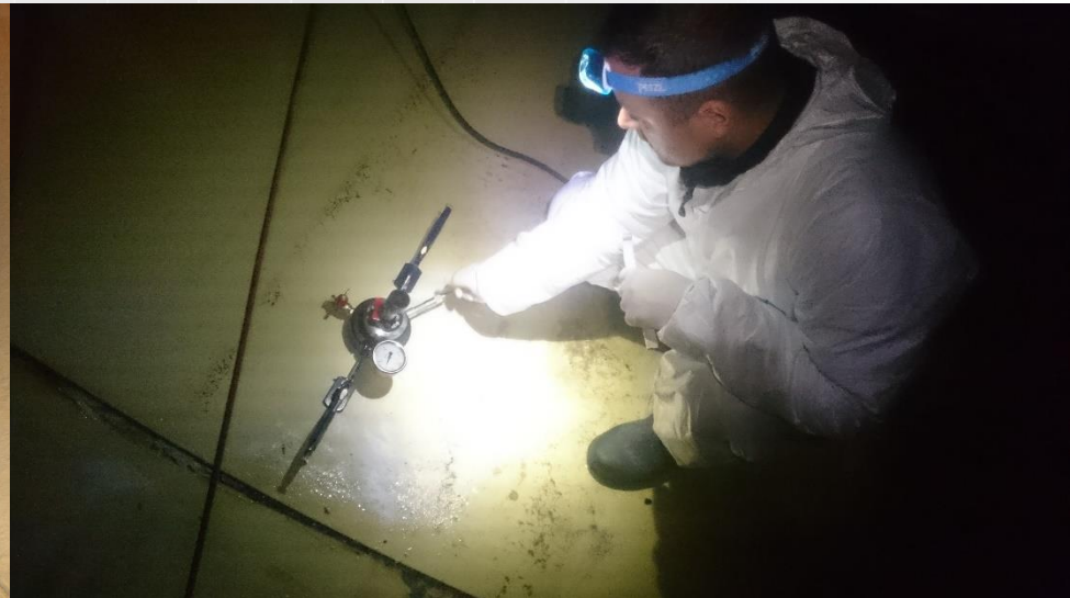
badanie szczelności rury GRP metodą GWT
