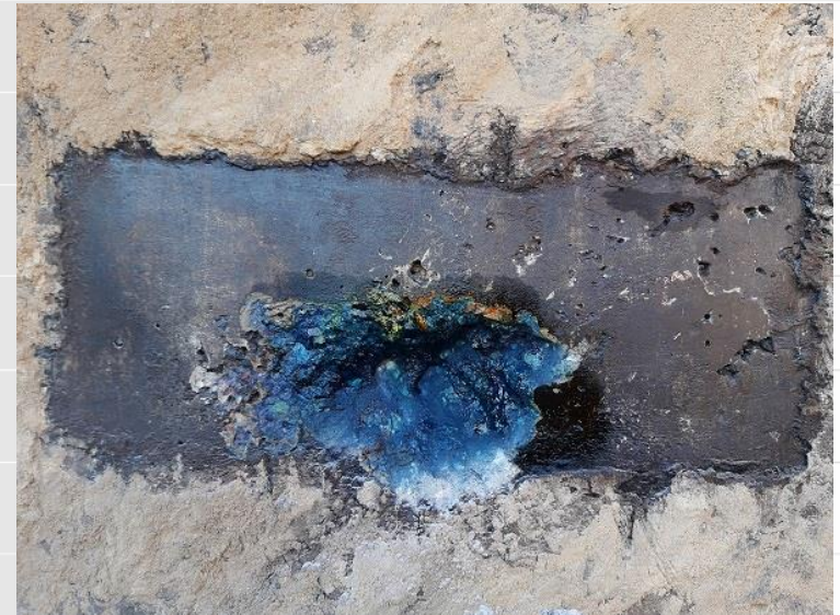
kontrola stopnia karbonatyzacji betonu
