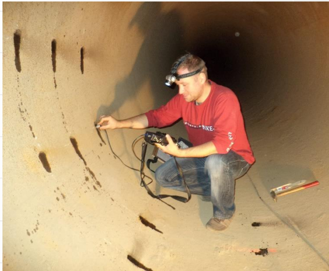
badanie grubości ścianki rury stalowej
