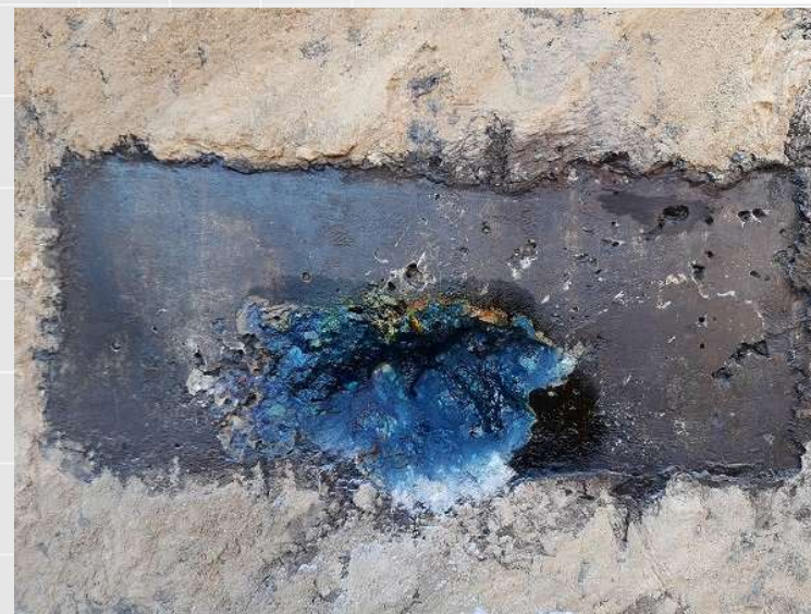
kontrola stopnia karbonatyzacji betonu
