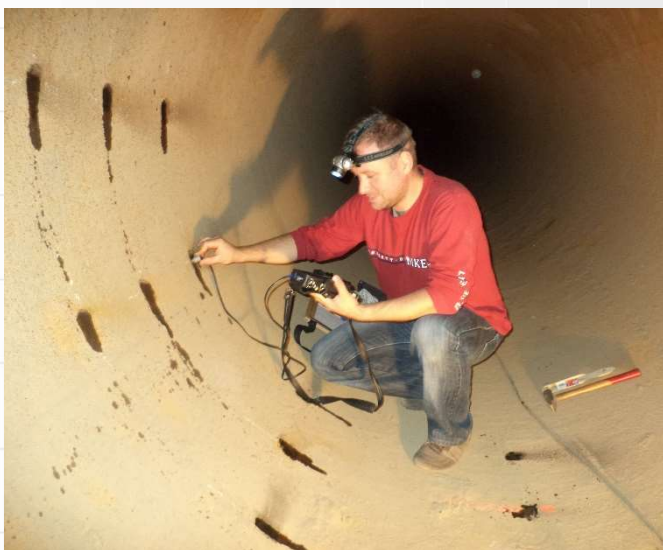
badanie grubości ścianki rury stalowej
